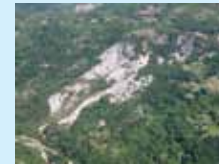
KLIZIŠTE GROHOVO THE GROHOVO LANDSLIDE ŽELJKO ARBANAS, RIJEKA, CROATIA
