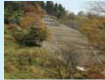
NA OVOJ KOSINI VIŠE NIKAD NEĆE NASTATI KLIZIŠTE THIS SLOPE WILL NEVER COLLAPSE AGAIN ALEXANDER STROM, MOSCOW, RUSSIA
