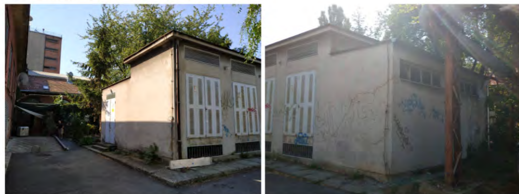
31 Pomoćni objekt - trafostanica
